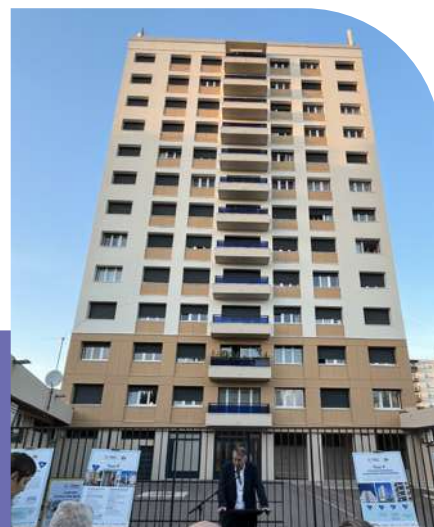
Copropriété Bellevue Tour - réhabilitée
